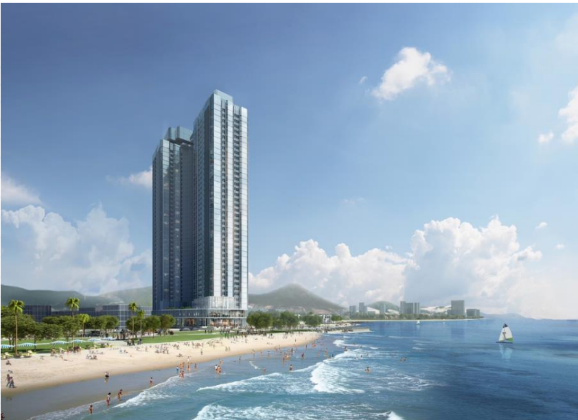
HÌNH 1: DỰ ÁN ALARCARTE HẠ LONG
